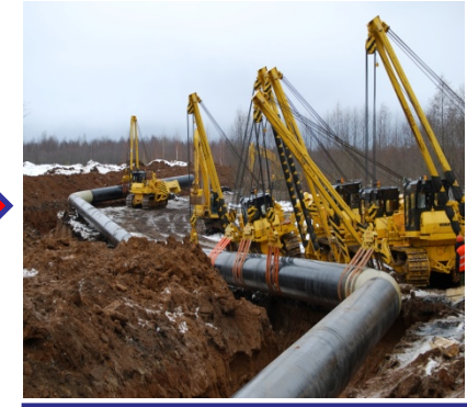
8. Входной контроль при строительстве (подрядчик)
