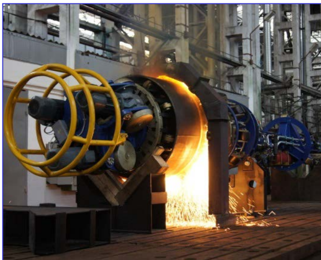
Сварка корневого слоя шва
