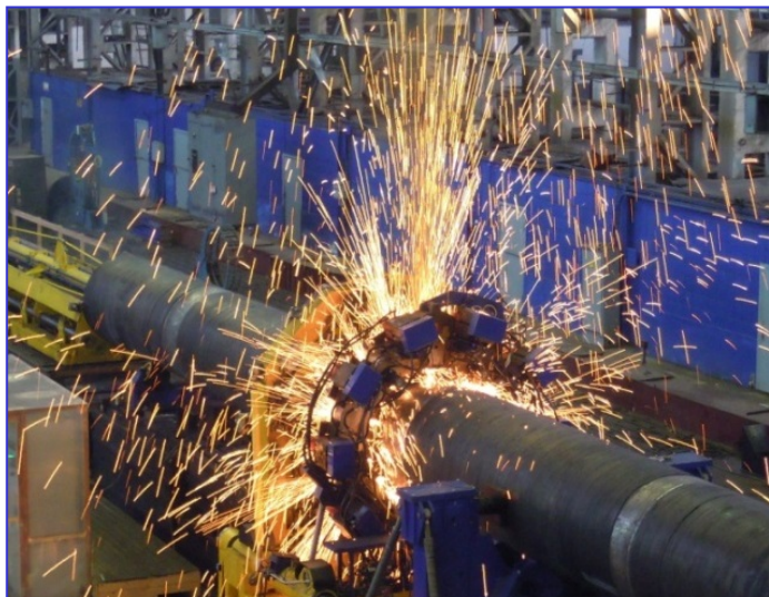
Сварка стыкового соединения
