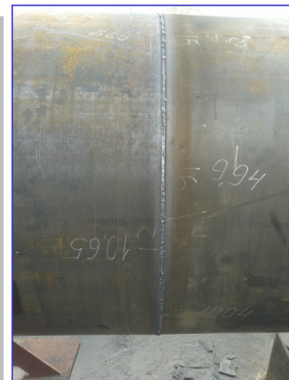
Внешний вид корневого слоя шва
