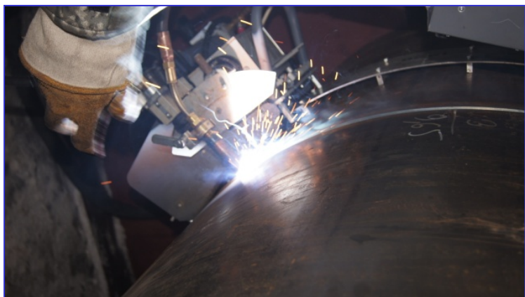
Сварка заполняющего и облицовочного слоя шва
