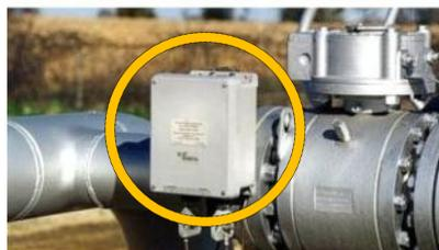
Электрическое отделение не подлежащих ЭХЗ заземленных элементов МГ
