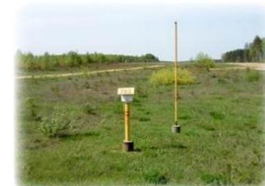
❖ Электрически отделяемые от подземного изолированного трубопровода конструкции инфраструктуры трубопровода: защитные и технологические заземления, запорная арматура, оборудование телемеханики
