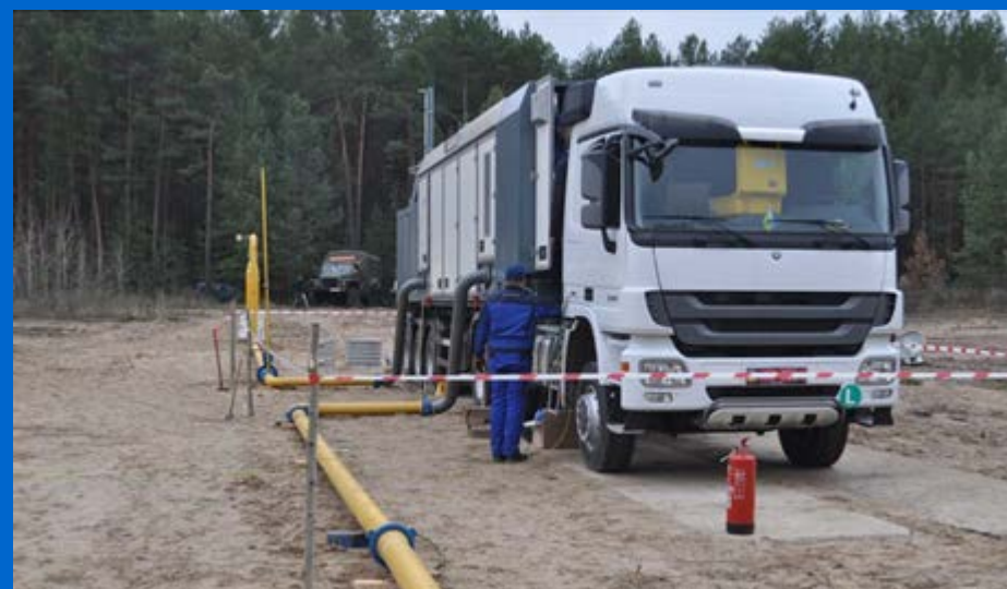
Использование технологии откачки газа с целью снижения давления газа в трубопроводе перед проведением стравливания.
