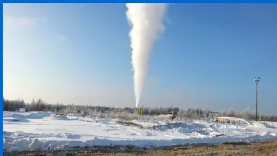
Отсечение повреждённого участка и стравливание газа из этого участка в атмосферу.
